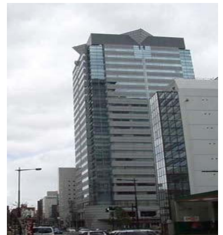
花京院再開発ビル
