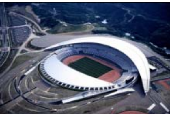
宮城県総合運動公園スタジアム
