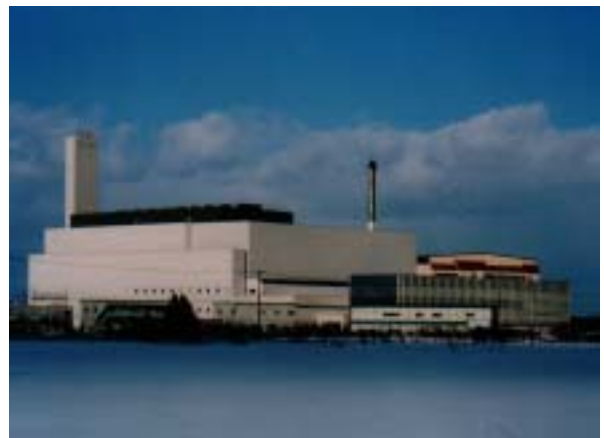
弘前新清掃工場
