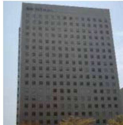
仙台MTビル
